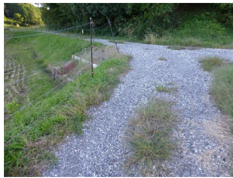
農道 (復旧状況)
