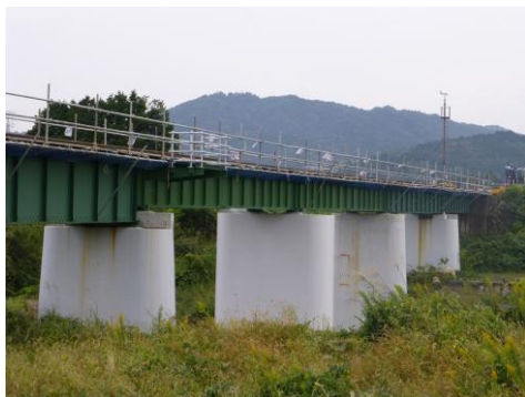
信楽高原鉄道 (橋桁設置後)
