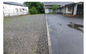
佐山荘駐車場(施工後)
