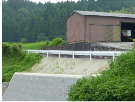
市道平海野線 (復旧状況)
