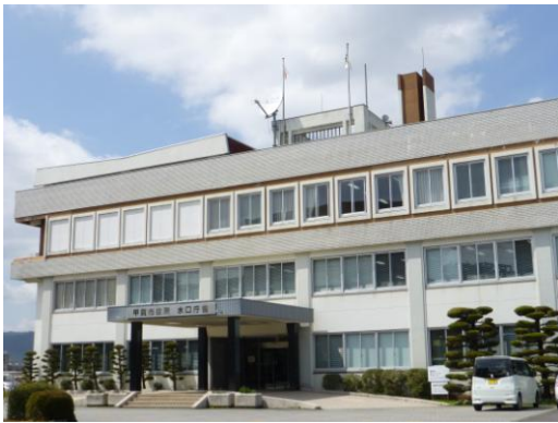
整備が予定されている水口庁舎
