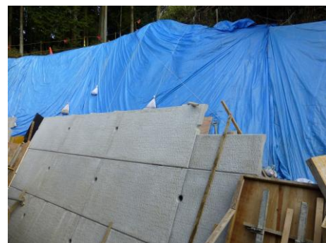
工事が進む急傾斜地対策事業 (甲賀町隠岐)
