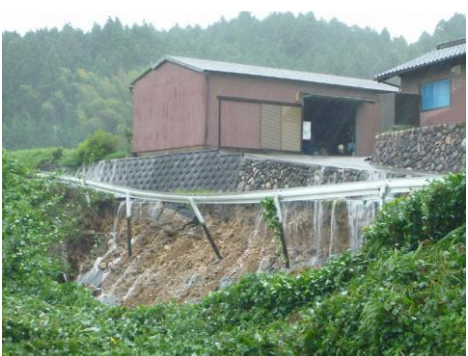
市道法面の崩壊（市道平海野線）
