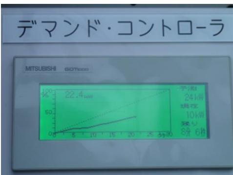
公共施設に設置されたデマンドコントローラ（電気使用量制御）
