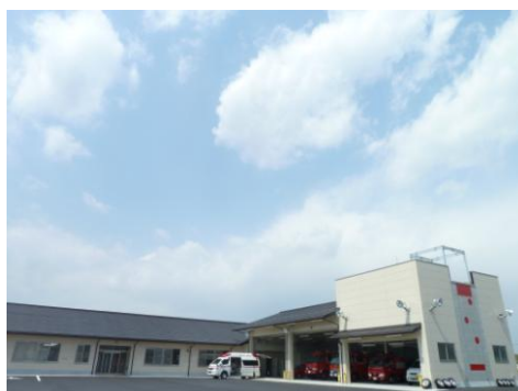
3月に竣工した甲南消防署
