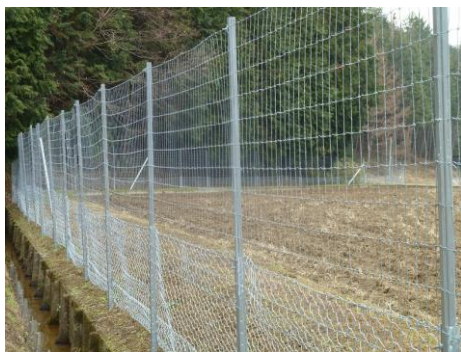
設置された総延長150kmの鳥獣侵入防護柵
